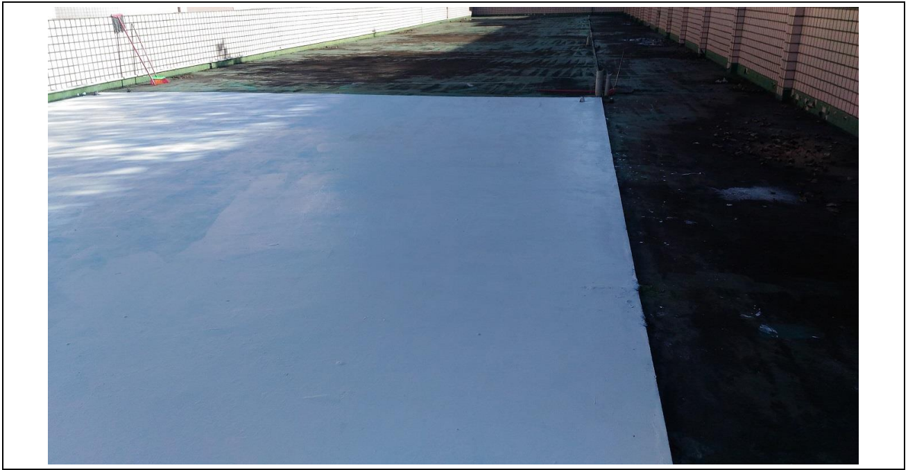
照片 3：教室頂樓塗刷隔熱塗料照片
