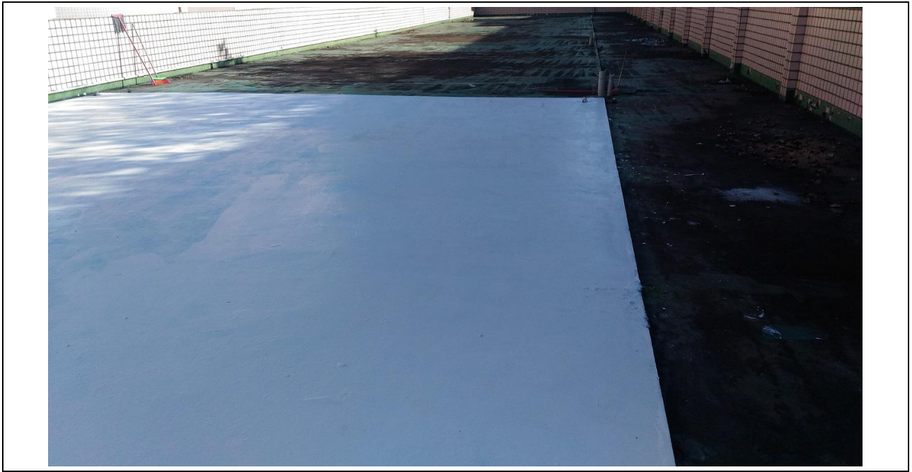
照片 3：教室頂樓塗刷隔熱塗料照片
