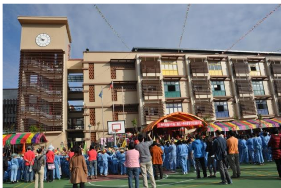
Pic.11：向陽樓梯不用水泥牆，而是直條斜板，兼具安全、通風、採光。
