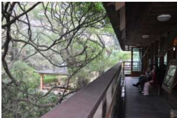
Pic.05：延伸屋簷阻擋陽光直射，氣窗向下斜開可散熱兼防雨水。
