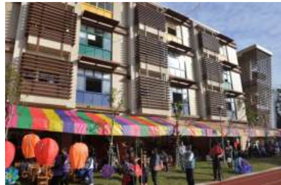
Pic.12：每間教室有延伸屋簷，窗戶有直條斜板，兼具安全、通風、採光。
